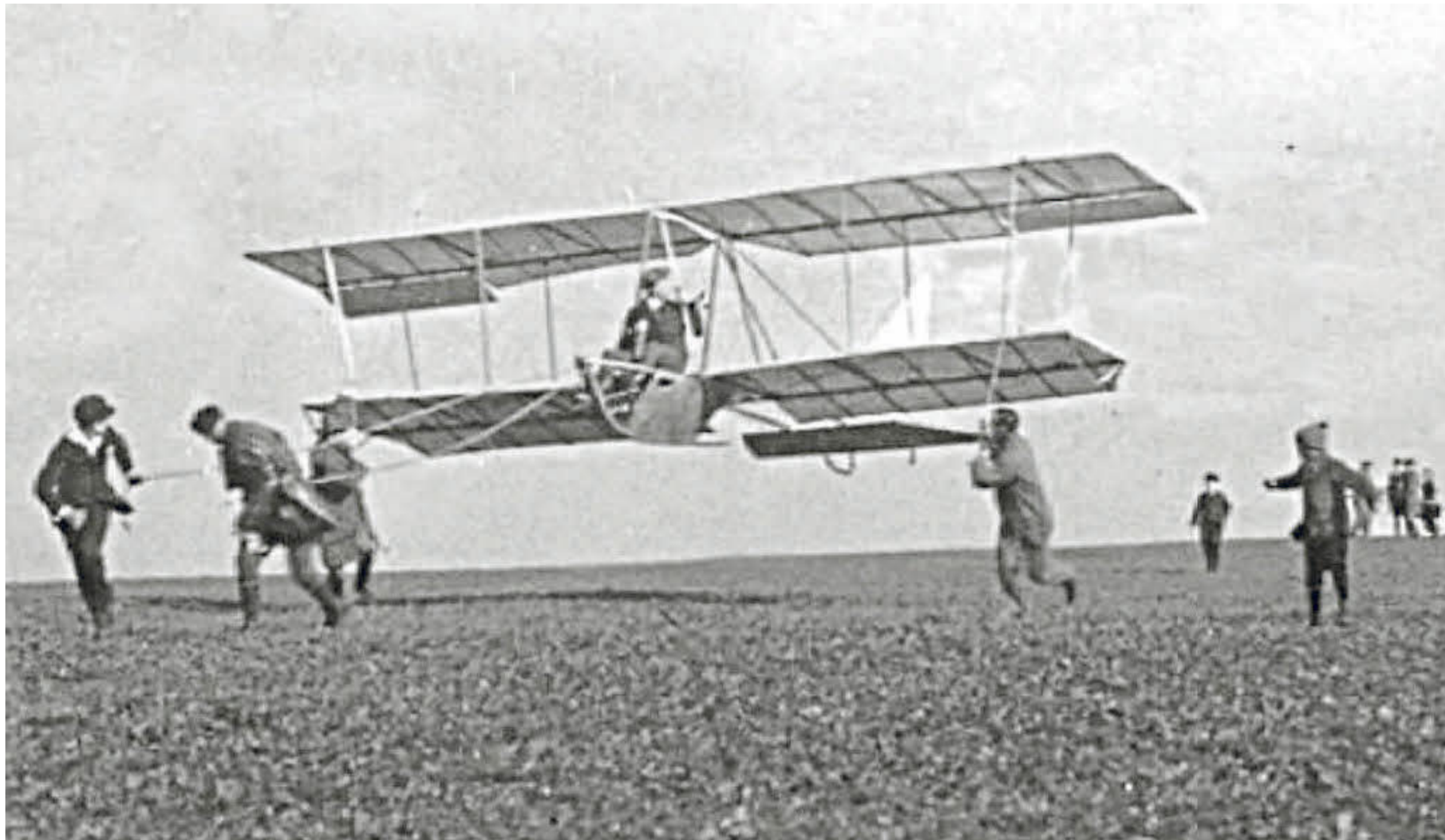
Auf geht's: Helfer ziehen den Sitzgleiter mit Stricken in die Luft, da der Flieger – anders als bei den kleineren Hängegleitern – selbst nicht mitlaufen kann.
